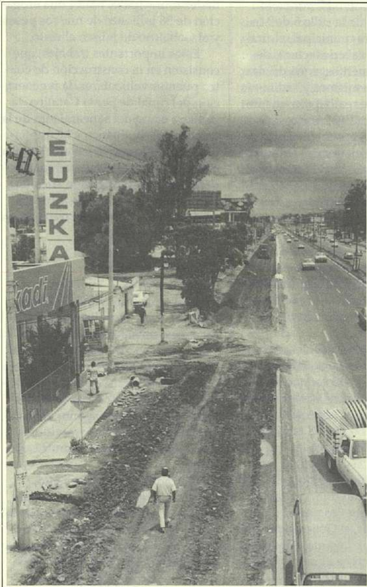
Avance en la construcción de carriles laterales en la avenida López Mateos
