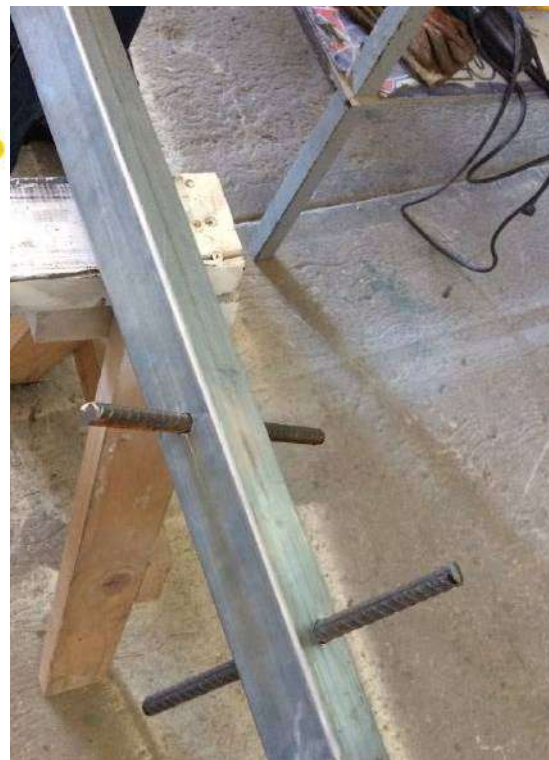
Figura II.7-2. Cimentación tipo para los postes de las señales bajas
